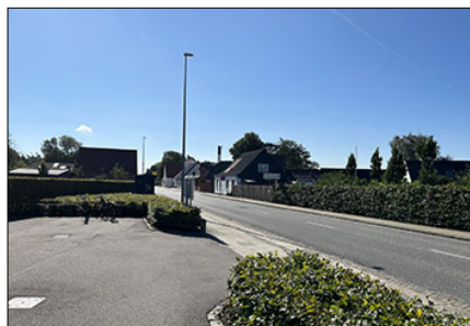
Fotopunkt 4 areal foran Isenvad Kirke. Bymæssig bebyggelse og beplantning slører kig til anlægget. Eksisterende skorsten ved Isenvad Varmeværk, Bygaden kan ses i baggrunden. Det vurderes, at grundet afstanden vil en ca. 4 meter højere skorsten ikke fremstå mere markant eller påvirke området væsentligt.
