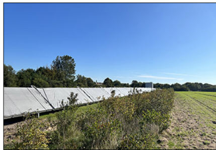
Fotopunkt 2 fra rammeområdet mod Isenvad by. Tæt beplantning slører indkig til byen og Isenvad Kirke. Eksisterende skorsten ved Isenvad Varmeværk, Bygaden kan ses i baggrunden.
